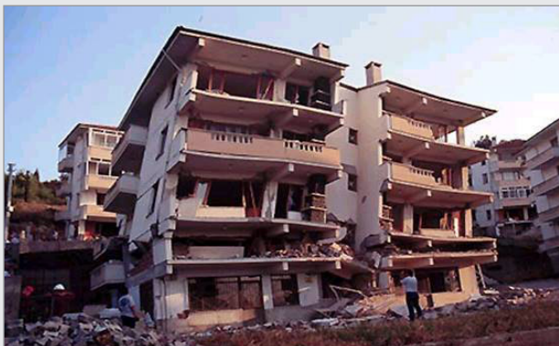
شکل ۱۱: تخریب در اثر حرکت پیچشی ساختمان
