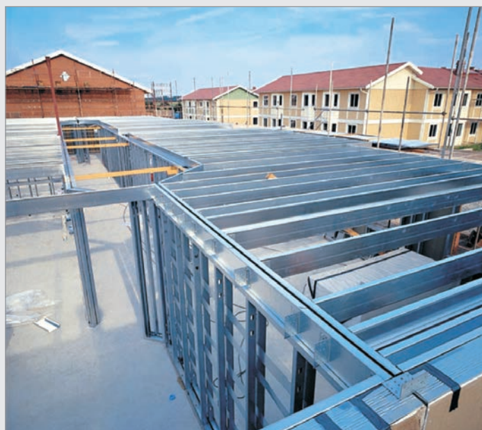
شکل ۳۰: سیستم سازه فولادی سبک (LSF)
