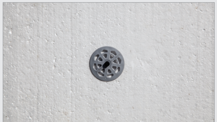
نصب بست‌های Termofix
