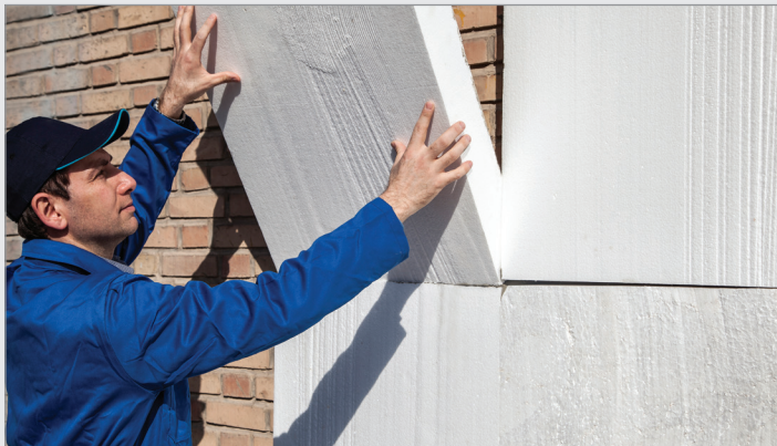
نصب قطعات عایق بر روی دیوار زمینه
