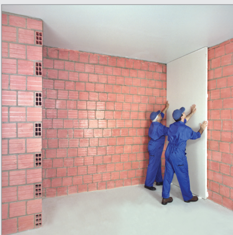
اجرای همزمان نازک‌کاری و عایق‌کاری با استفاده از صفحات گچی عایق‌دار
