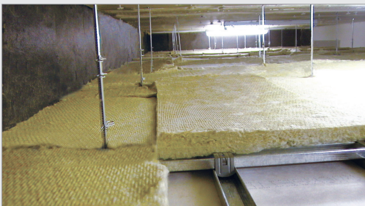
عایق کاری پیلوت
