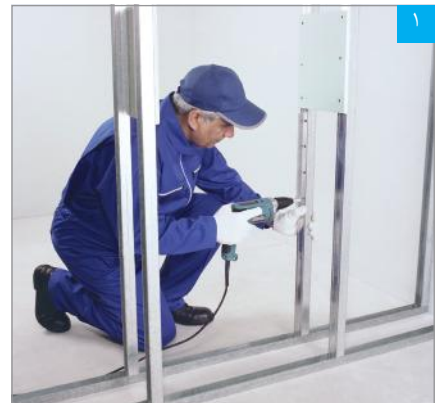
اتصال قطعات نبشی L25 به استادهای مجاور
