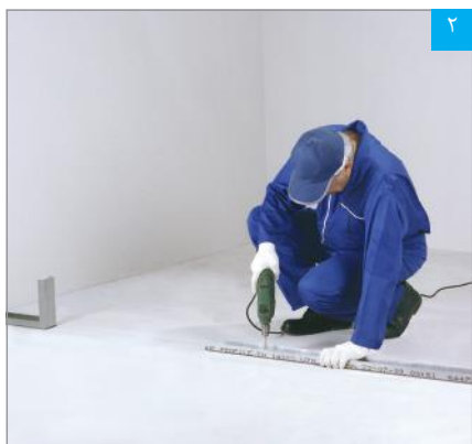
نصب رانر کف
