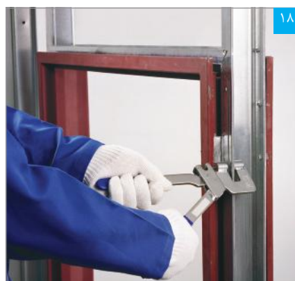
۱۸ اتصال رانر نعل درگاه به استاداها با پانچ
