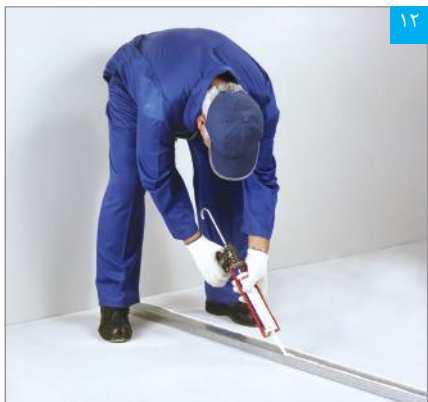
اجرای دو ردیف خمیر سیلیکون (یا نوار عایق) بر پشت جان استادهای جانبی
