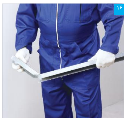
۱۶ خم کردن انتهای رانر نعل درگاه
