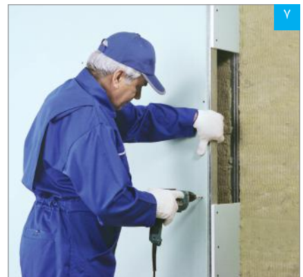
اجرای پنل‌ها در طرف دیگر دیوار (پنل‌ها نسبت به سمت اول به صورت حصیرچین اجرا می‌شوند)
