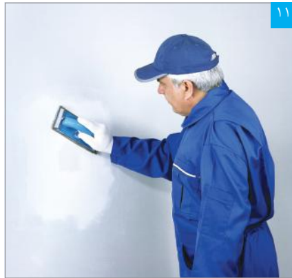
پرداخت سطح بتونه‌کاری شده و آماده‌سازی جهت پذیرش پوشش نهایی
