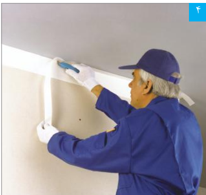
۴ برش اضافات نوار چسب جداکننده پس از خشک شدن بتونه
