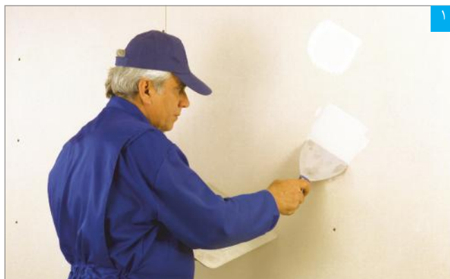
اجرای بتونه در محل پیچ‌ها
