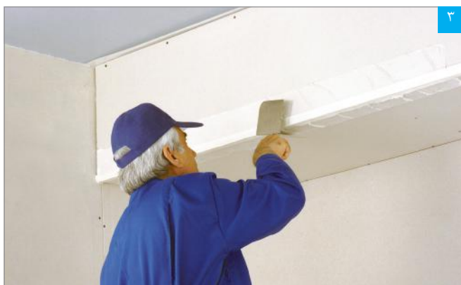
۳ تثبیت و شکل دهی نوار درزگیر با کاردک زاویه خارجی
