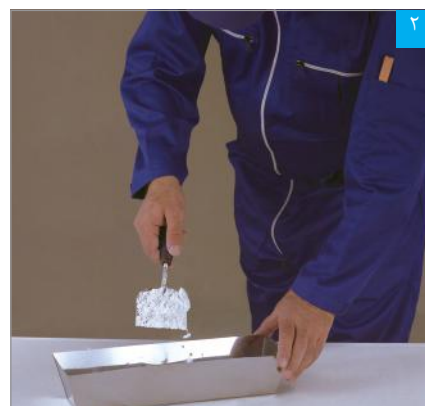
ریختن پودر بتونه در آب
