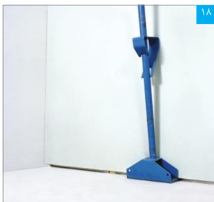
پنل‌ها بوسیله جک مخصوص به نحوی بر روی زیرسازی قرار می‌گیرند که ۱ سانتی‌متر با کف فاصله داشته باشند
