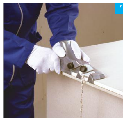
اجرای پخ با پخ زن
