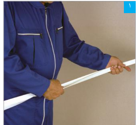
۱ خم کردن نوار درزگیر با دست
