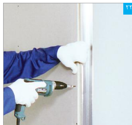
پنل باید در جهتی نصب شود که لبه آزاد آن به سمت دهانه باز استادا قرار گیرد
