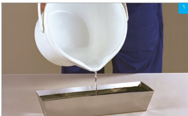
ریختن آب در ظرف تهیه بتونه
