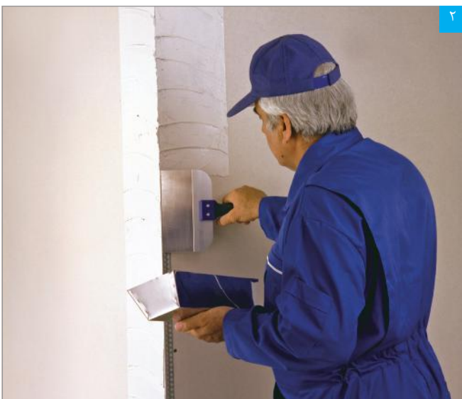
اجرای بتونه روی سازه محافظ گوشه
