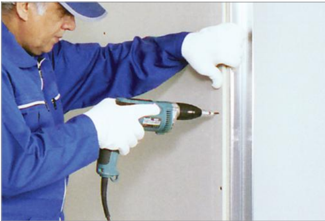
پنل باید در جهتی نصب شود که لبه آزاد آن به سمت دهانه باز استاد قرار گیرد
